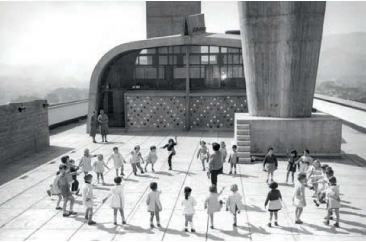
Unite d'Habitation - Marseille - 1945 ©
